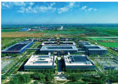
建设中的雄安新区（2018年）
