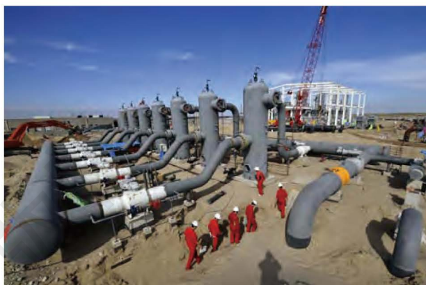
图 3-2-12 西气东输二线管道工程建设
