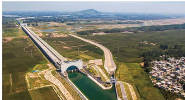
图 3-2-4 南水北调中线沙河渡槽
