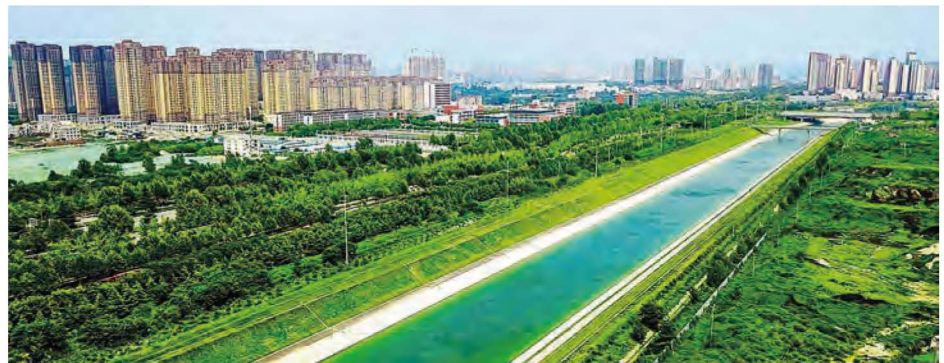
郑州南水北调生态文化公园，长约 8 千米的干渠两侧，各有 200 米宽的绿化带。靠近干渠不设置人行步道和游乐设施，尽量减少人类活动对渠水的影响。
