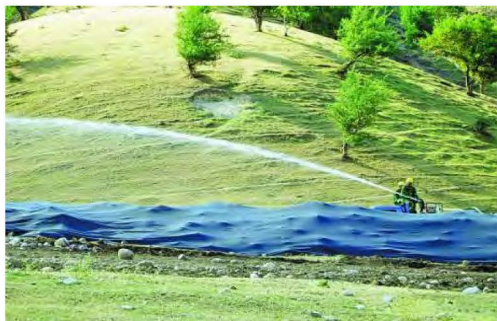
图 3-2-14 西气东输管道工程进行生态恢复作业
