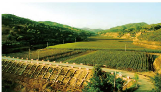
左为打坝淤地拦蓄泥沙；右为修建水平梯田。 图 2-4-11 治理水土流失的工程措施
